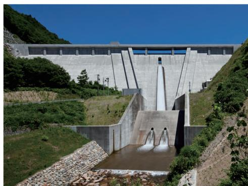
ダム堤体下流面：三枚の導流壁が下部に絞り込まれた、我が国でも初めての特徴的なデザインにより、力強くも柔らかな表情を作り出した。水理実験により安全性を検証し、化粧に留まらない構造まで踏み込んだ本質的なダムデザインを実現している。
